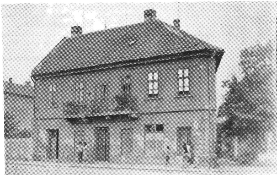
Fig. 11. Clădirea Piața Veche nr. 1 (colț cu str. Tribunalul Dobra).
